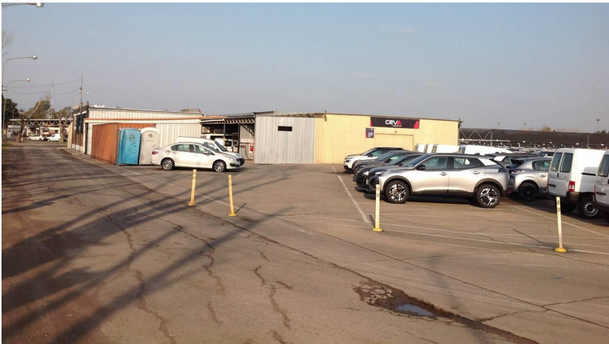
Figura 3.38 Zona de estacionamiento sin cobertores, para estructuras tipo carport. Los galpones no serán retirados.
