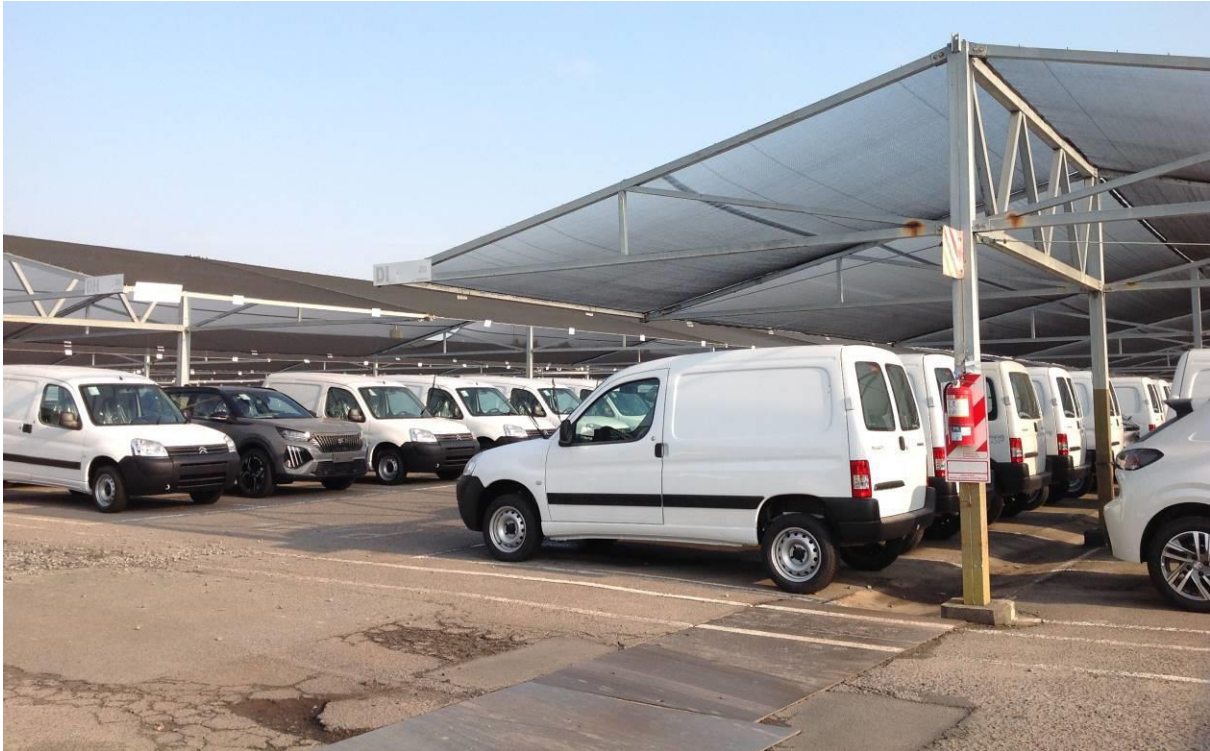
Figura 3.39 Zona de estacionamiento con cobertores, para estructuras tipo carport.
