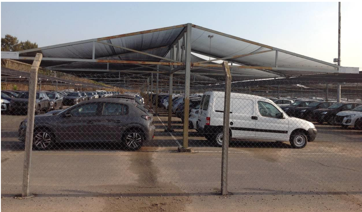
Figura 3.34 Zona de estacionamiento con cobertores (delimitado por alambrado), para estructuras tipo carport, Detalle.
