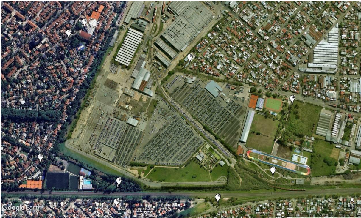
Figura 3.20 Receptores detectados en el entorno del predio del proyecto (predio a ser ocupado por el PSP en el centro de la imagen). Numeración según listado previo.
