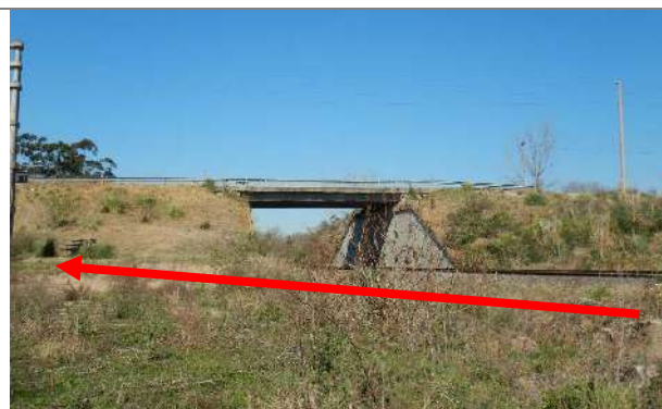
Foto 3.6-34. Paso a desnivel de calle Alfredo Viola.
