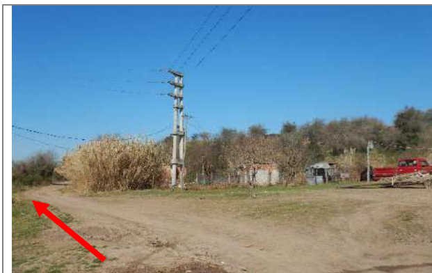
Foto 3.6-29. Asentamientos de vivienda en sector de la traza y líneas de alta tensión.
