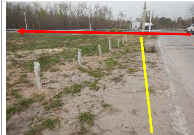
Foto 3.6-52. Desviación de la traza hacia calle de ingreso a empresa Petromining S.A.
