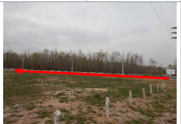
Foto 3.6-53. Continuación de la traza hacia calle de ingreso a empresa Petromining S.A. por costado norte, paralelo a terrenos de empresa Euroamérica.
