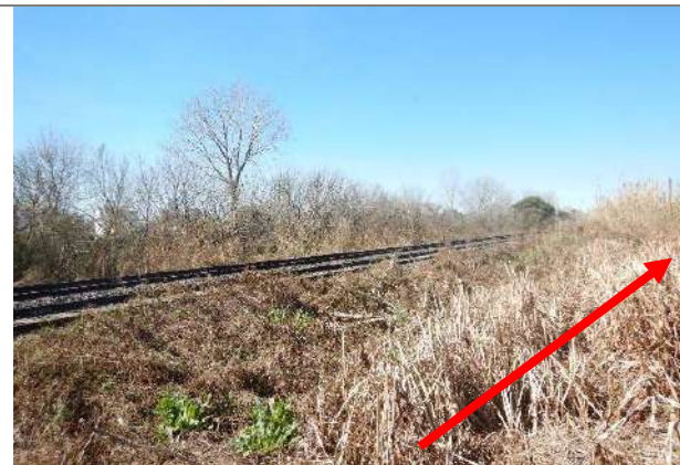
Foto 3.6-13. Continuación de la traza de poliducto paralela a vías de ferrocarril.
