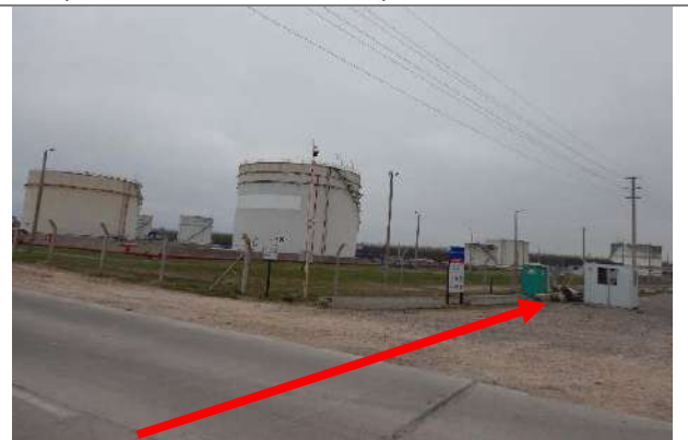
Foto 3.6-57. Desvío de la traza hacia el ingreso a empresa Petromining S.A.
