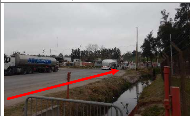
Foto 3.6-5. Traza del Poliducto paralela a canal pluvial en Av. Coronel A. de Valle Larrabure.
