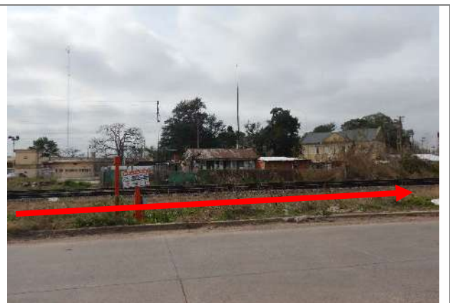
Foto 3.6-10. Trazo por Av. Hipólito Yrigoyen. Sigue la misma traza que el Oleoducto de alta presión Bransen-Campana de Axion.
