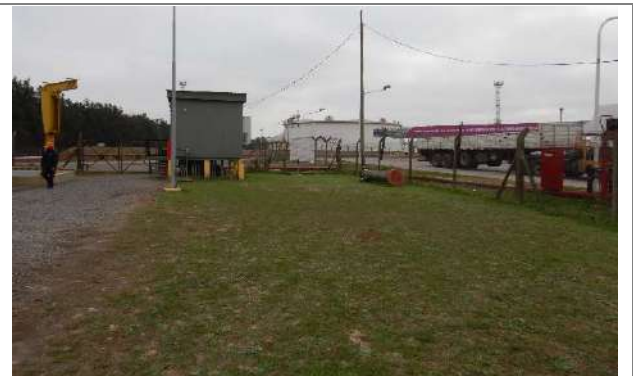
Foto 3.6-2. Sitio de inicio de la traza del Poliducto superficial dentro de la Terminal Campana de PAE. 34° 10'8.08"S; W58° 56'39.44"O Dirección NE.
