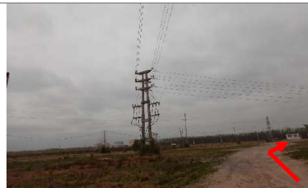
Foto 3.6-41. Interferencia de la traza con línea de alta tensión. 34° 10'40.88"S; 58° 56'0.29"O. Dirección NE.
