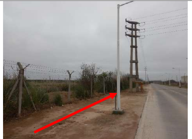
Foto 3.6-55. Continuación de la traza hacia calle de ingreso a empresa Petromining S.A. por costado norte, paralelo a terrenos de empresa Euroamérica.
