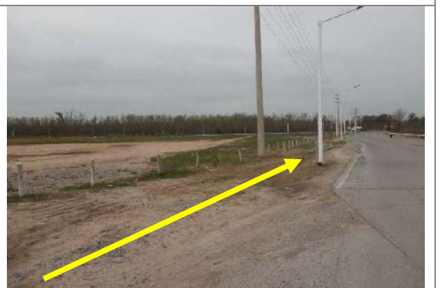
Foto 3.6-47. Vista de alternativa de traza en dirección SE en calle Alfredo Viola, costado este paralelo al terrenos de la empresa Euroamérica.
