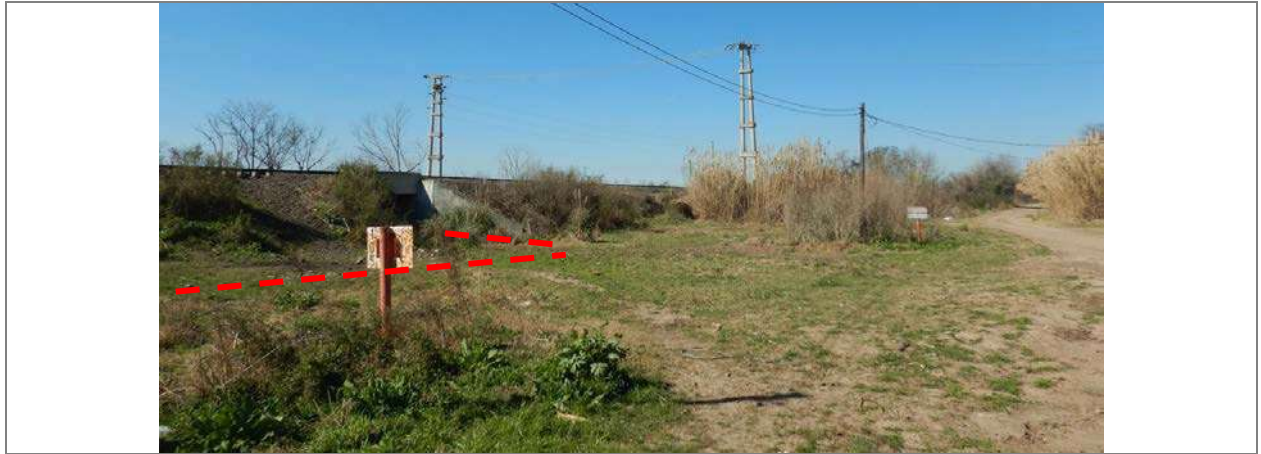
Foto 3.5-2. Cruce de túnel de vías frente a asentamiento.
