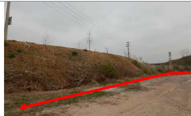
Foto 3.6-39. Desviación de traza de poliducto paralelo a calle Alfredo Viola.
