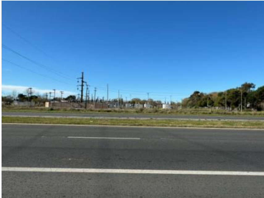
Foto 5. Tomada a unos 20 metros al sur de la LAT 132 kV aérea, sobre la banquina de la RP 11, mano a Mar del Plata, en el punto aproximado donde se ejecutará la apertura de la LAT Mar de Ajó – Las Toninas ; sobre la mano contraria se observa el frente de la ET Mar del Tuyú sobre calle 16, entre 73 y 74, de la misma localidad
