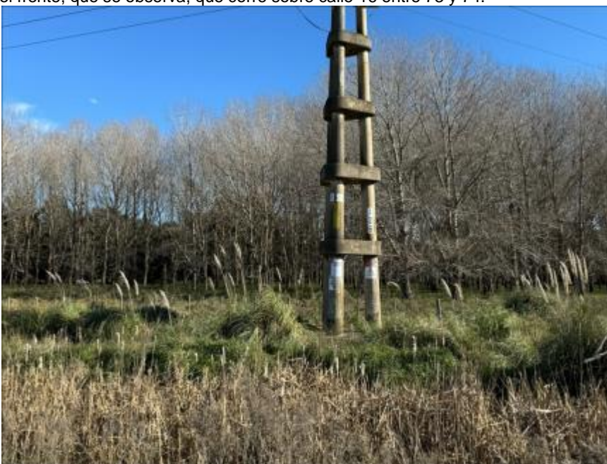
Foto 4. Tomada en el punto de la foto anterior, en sentido contrario, se observa el soporte N° 126 desde el que se hace el cruce actual de la Autovía; en primer plano el zanjón, ancho, profundo y con agua y totoras. La base del soporte se observa en seco y bien afirmada. No se visualiza ningún tipo de accesorio o límite que impida el acceso al zanjón o canal, que se encuentra colmatado de agua y vegetación.
