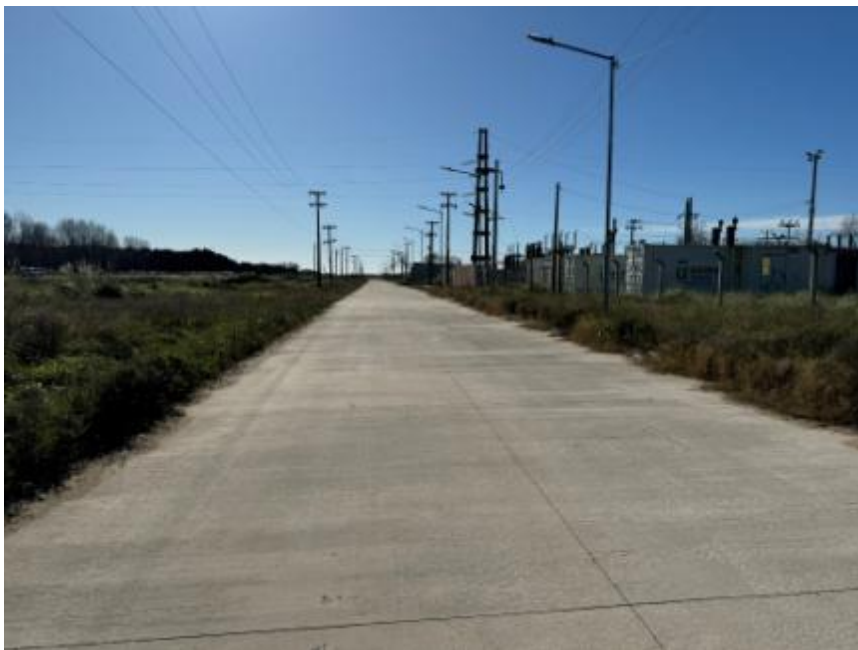
Foto 25. Tomada en el punto de la foto 23, observando en sentido norte – hacia calle 73 – se visualiza la calle 16 de hormigón, que pasa frente a la ET, quedando la ET del lado derecho de la foto, y luego sobre la izquierda de la calle, la zanja o canal de pluviales sin ningún tipo de restricción o limitación para acceder al mismo.
