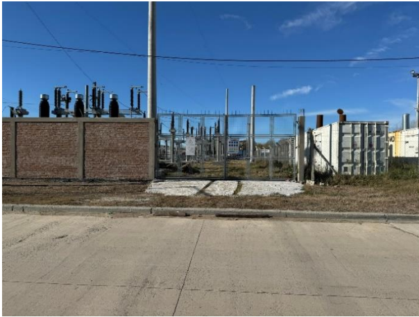
Foto 3.5. Vista del portón del frente de la ET Mar del Tuyú sobre calle 16, con acceso al área actualmente activa
