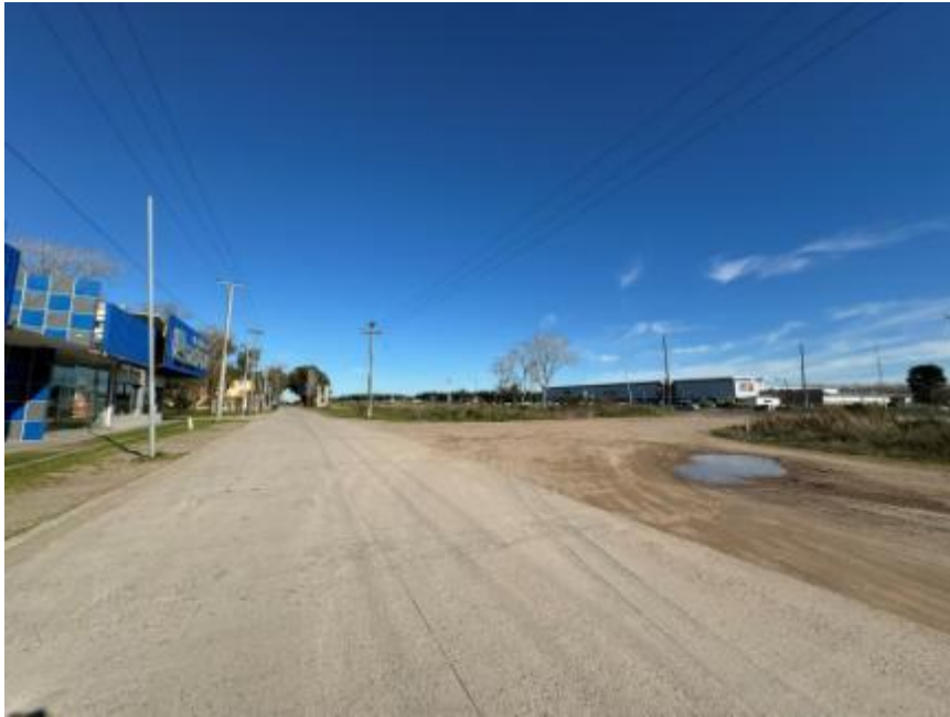
Foto 27. Tomada a unos 500 metros del frente de la ET sobre calle 16, se observa el amplio acceso a esta calle, para vehículos largos y pesados, desde la mano camino a Bs As de la Autovía; al fondo a la derecha se observa el enorme galpón de un supermercado ubicado frente al acceso de calle 79 a Mar del Tuyú.
