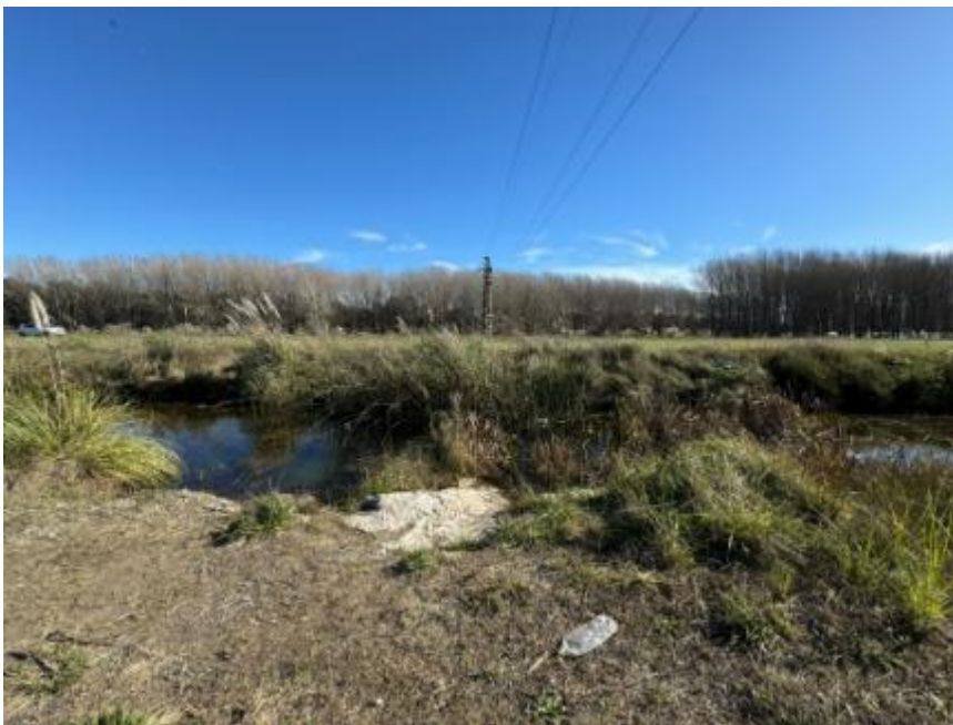
Foto 9. Tomada sobre al zanjón – observado en la Foto 8 - que se encuentra en la banquina de la Autovía, a unos 30 metros del portón de la ET sobre calle 16, a la altura de la LAT 132 que cruza hacia la estación transformadora. Se visualiza el zanjón, ancho, y cubierto de agua.
