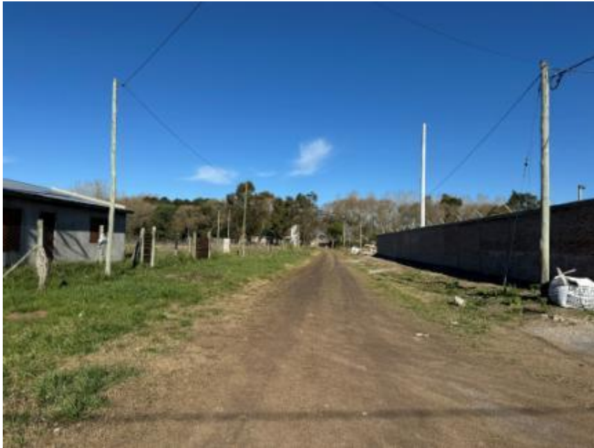
Foto 17. Tomada en el punto de la foto anterior, observando hacia el sur, hacia la calle 15 bis, donde puede apreciarse, al igual que en la calle 73, que no se cuenta con ningún tipo de consolidado, cordón cuneta o zanjas de escurrimiento. El paredón continúa unos 50 metros hasta mitad de cuadra.
