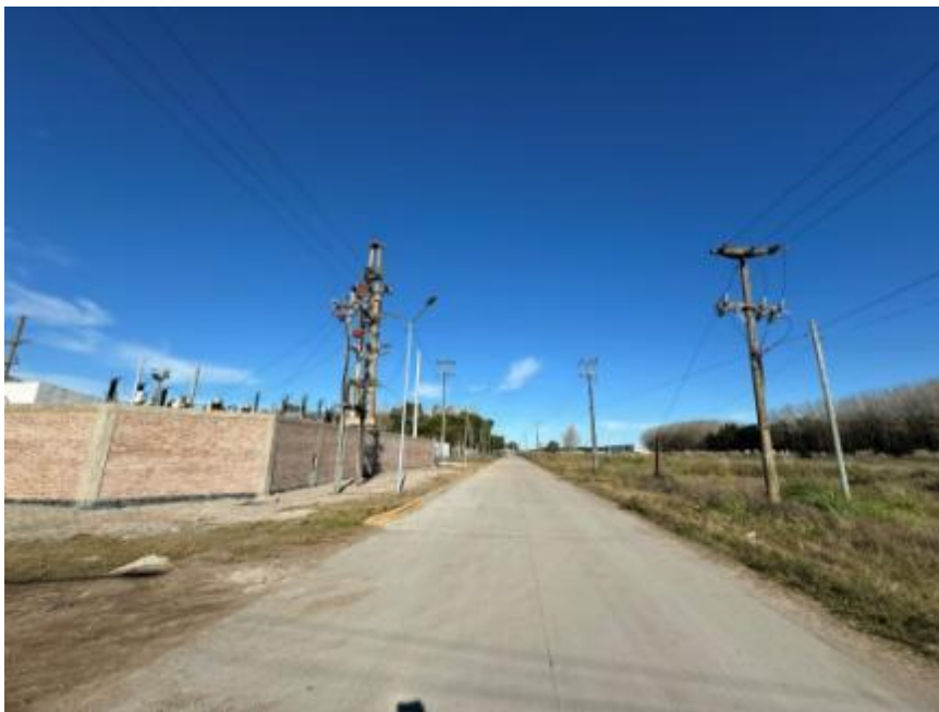
Foto 11. Tomada sobre la esquina de calle 16 esquina 73. Se observa un pavimento de hormigón, que se inicia en la calle 79 – al fondo a unos 600 metros – sirviendo de acceso directo, firme y seguro a la ET, incluso para vehículos de gran porte. El pavimento de hormigón termina a 300 metros, en sentido contrario al que se observa, donde se llega a un camino de tierra sin consolidar y donde no hay accesibilidad desde la RP 11.
