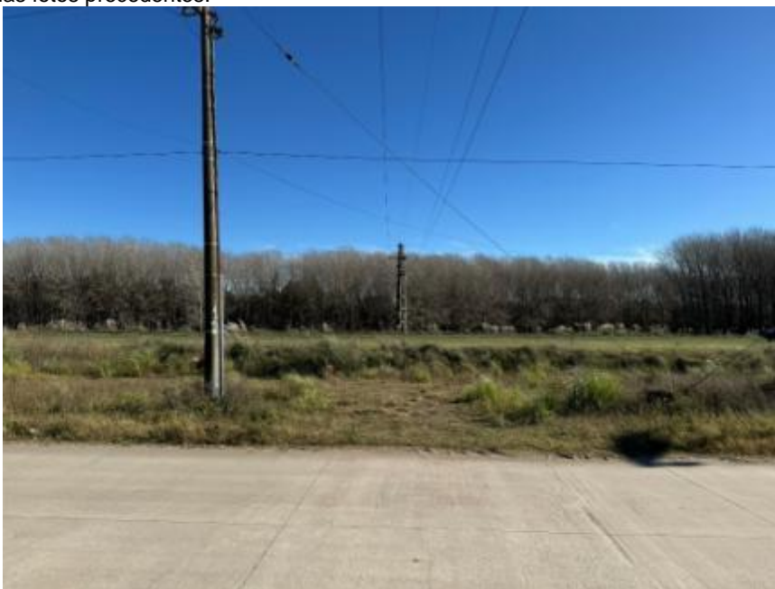
Foto 8. Tomada sobre la calle 16, debajo de los conductores de la LAT 132 kV que viene del soporte N° 126, cruzando la autovía, e ingresa a la ET Mar del Tuyú como se observa en la foto anterior. También en esta banquina de la Autovía RP 11, se observa un importante zanjón o canal de pluviales, distante unos 30 metros de la línea municipal. No se presenta a lo largo de la banquina ningún tipo de accesorio o guarda que impida llegar al zanjón. Se observa un importante desnivel, incluida la calle pavimentada, advirtiéndose que el sentido de escurrimiento de toda el área, se efectúa hacia el zanjón o canal señalado.
