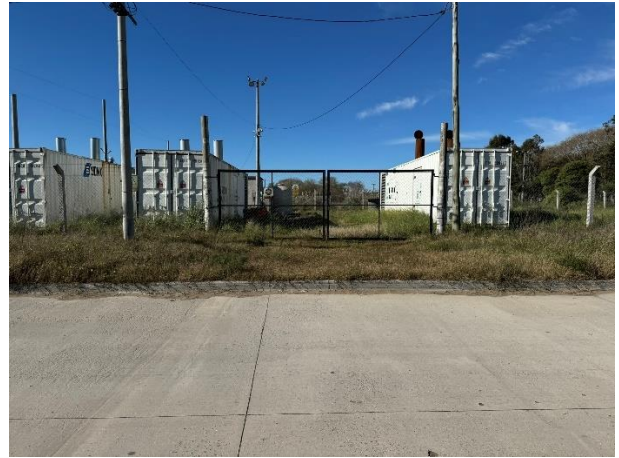
Foto 3.6. Vista del portón del frente de la ET, sobre calle 16, pavimentada, con acceso al área de depósito de contenedores de grupos generadores.
