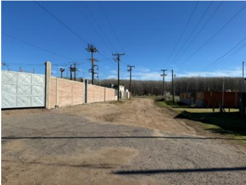
Foto 15. Tomada en la esquina de calle 73 y 15 bis, observando en el sentido de la Autovía RP N° 11. Se visualiza una calle de tierra, flanqueada de líneas aéreas de 13,2 kV; sobre la derecha de la foto, dos predios con viviendas sobre la esquina de 15 bis.
