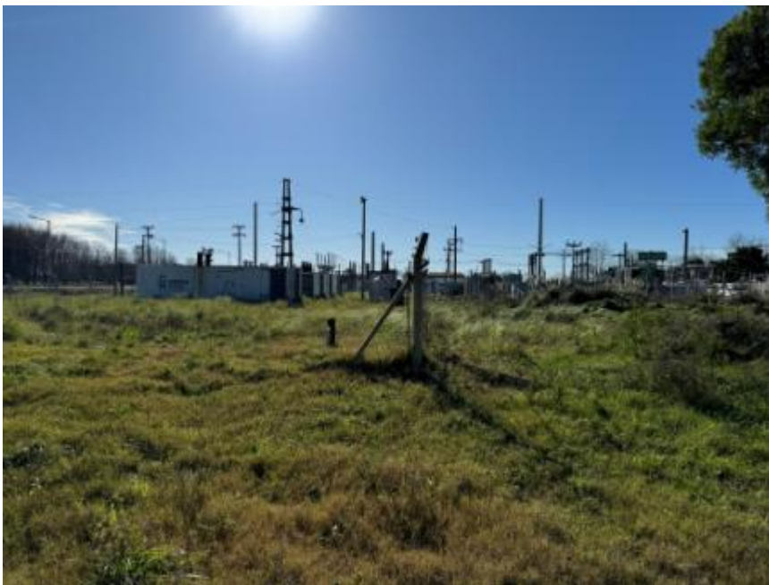
Foto 21. Tomada a 50 metros de la esquina de 15 bis, sobre la calle 74, se observa el predio cubierto de vegetación herbácea. Al fondo, se visualiza el área activa de la ET, volcada sobre calle 73.
