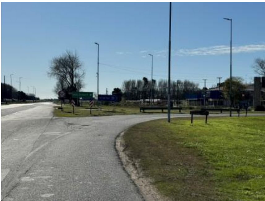
Foto 29. Tomada previo al acceso de calle 79 a Mar del Tuyú, desde la mano a Bs As de la Autovía RP N° 11; a unos 200 metros de este punto se encuentra el acceso a calle 16, desde donde se llega por calle 16 pavimentada a la ET Mar del Tuyú, que se ampliará con la instalación de dos transformadores de 132/33/13,2 kV de 30/20/30 MVA, y con una vinculación en doble terna de 132 kV, de 122,92 metros que cruza la Autovía en forma aérea, desde la apertura de la LAT 132 kV Mar de Ajó – Las Toninas.
