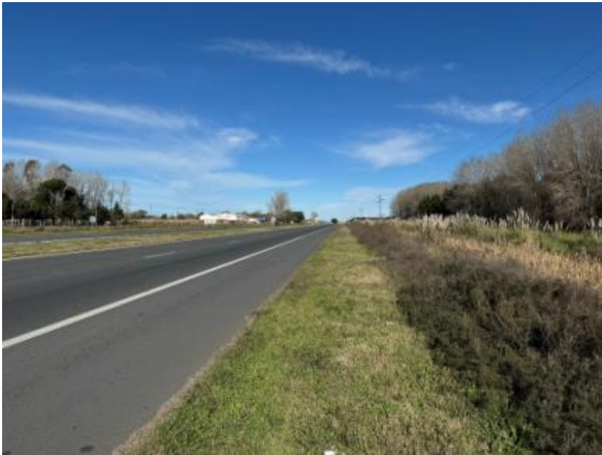
Foto 6: Tomada en el punto de la foto anterior, observando en sentido hacia Mar del Plata; se observa, a fondo el soporte N° 127, y luego la bifurcación del Acceso a Mar del Tuyú por calle 79.
