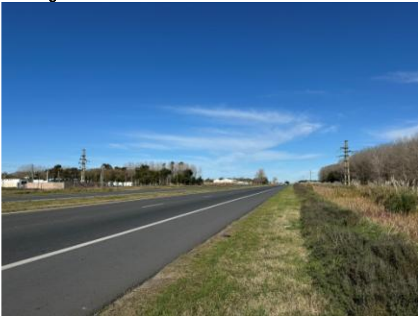
Foto 1. Tomada desde la banquina de la Autovía Ruta Provincial N° 11 (RP 11), sobre la mano a Mar del Plata), a unos 50 metros de la LAT 132 kV que, desde un soporte triple retención de la LAT 132 kV Mar de Ajó – Las Toninas, la cruza en forma aérea, para alimentar actualmente la ET Mar del Tuyú. Se visualiza, a la izquierda de la foto, sobre el lado contrario de la RP 11, el muro perimetral de la ET, el soporte de la LAT de cruce y equipamiento en operación.
