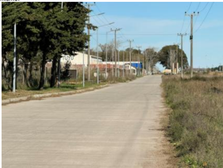
Foto 26. Tomada en el punto de la foto anterior, en sentido contrario; se observa la calle 16 de hormigón, por donde transitarán los vehículos y equipos para acceder a la ET desde la RP 11. El acceso a la calle 16, desde la autovía, se presenta luego, y a unos 100 metros, del arco de ingreso a la localidad de Mar de Ajó por calle 79, frente a una casa de artículos para la construcción con un gran predio de acopio de materiales, distante unos 500 metros de la ET Mar del Tuyú.
