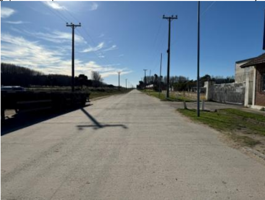
Foto 28. Tomada en el punto de la foto anterior, observando en sentido contrario; se visualiza la calle 16 que lleva a la ET, flanqueada por líneas de media tensión originadas en la misma ET. Sobre la derecha de la foto, un comercio de materiales para la construcción y corralón; sobre la izquierda, un semi largo de transporte de materiales y luego, el canal de pluviales y la Autovía.
