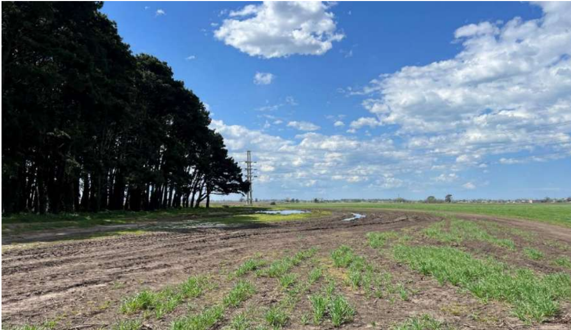
Vista SO, Pantalla Forestal Parque Industrial Savio. Calle de conexión predios interiores
