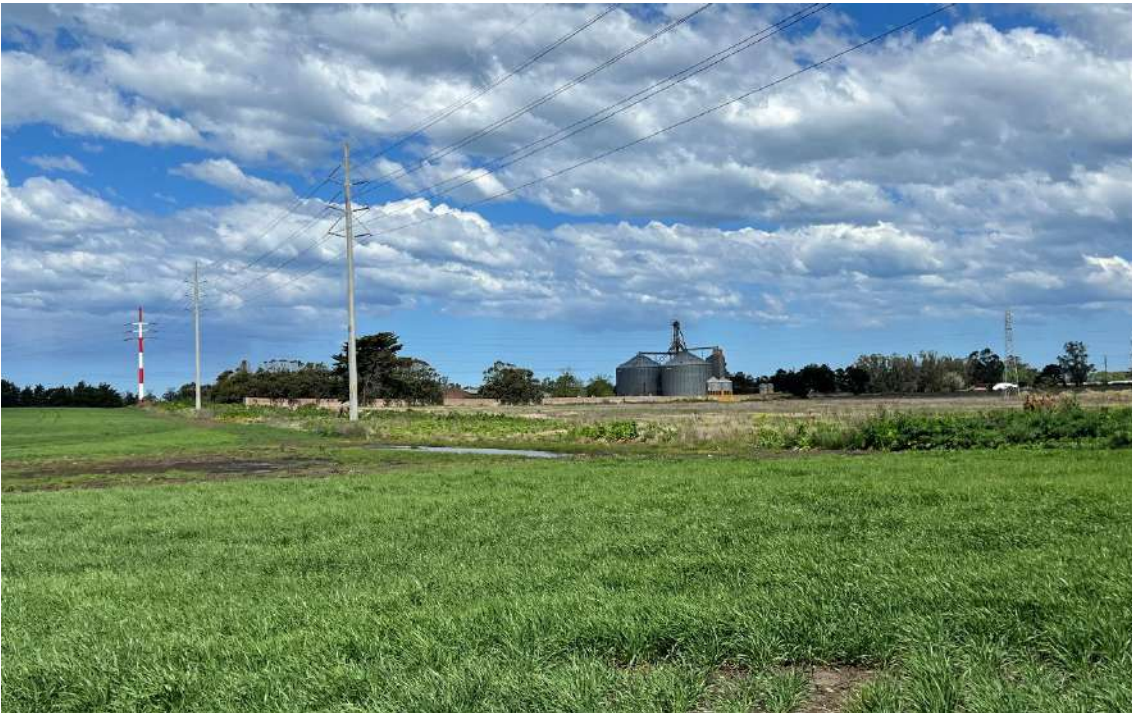
Líneas de media y alta tensión. Lindero silos acopio granos
