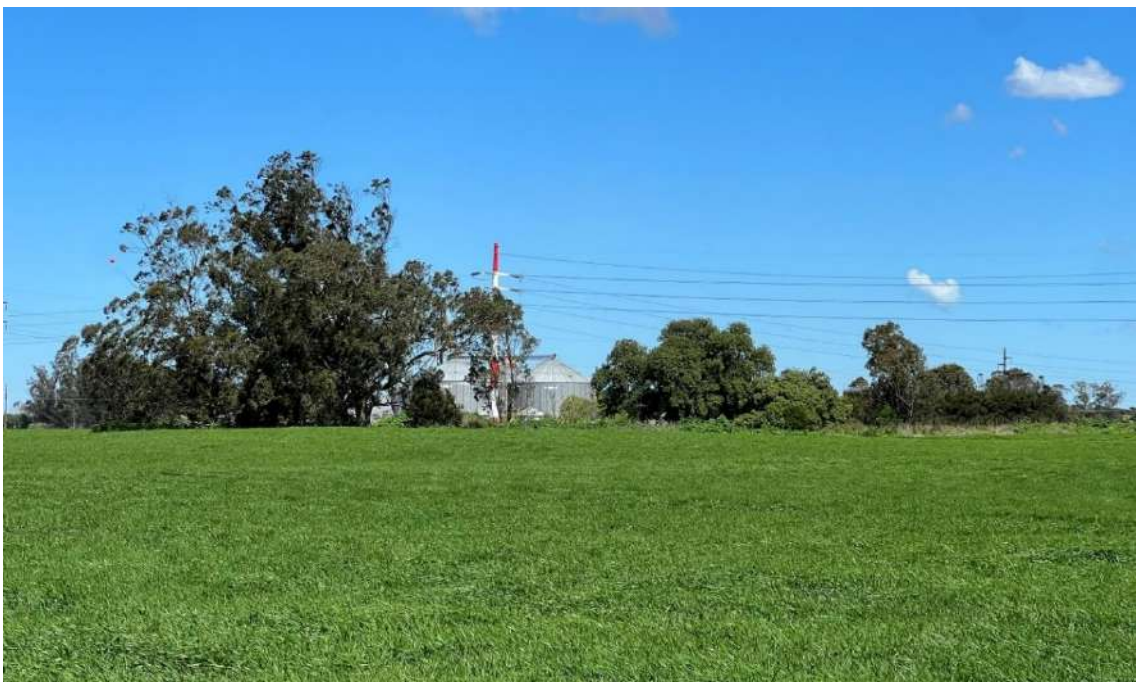
Vista NE, Pantalla Forestal depósito de granos Villar, frentista a la ruta lindero al parque
