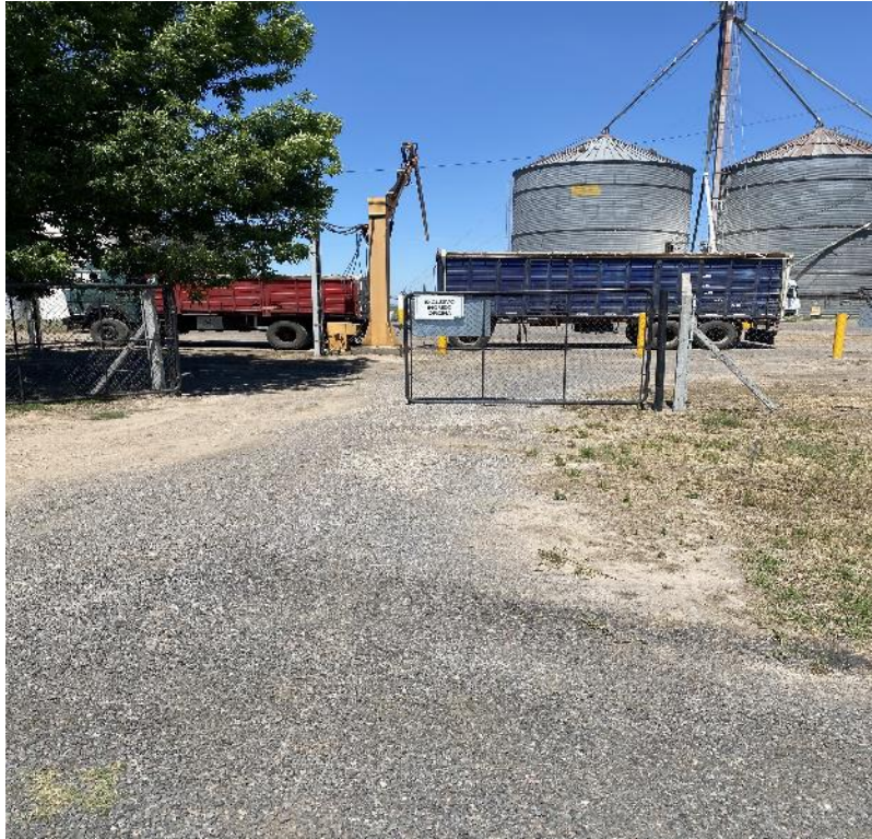
Imagen 3: Ingreso a planta desde ruta Nacional 8
