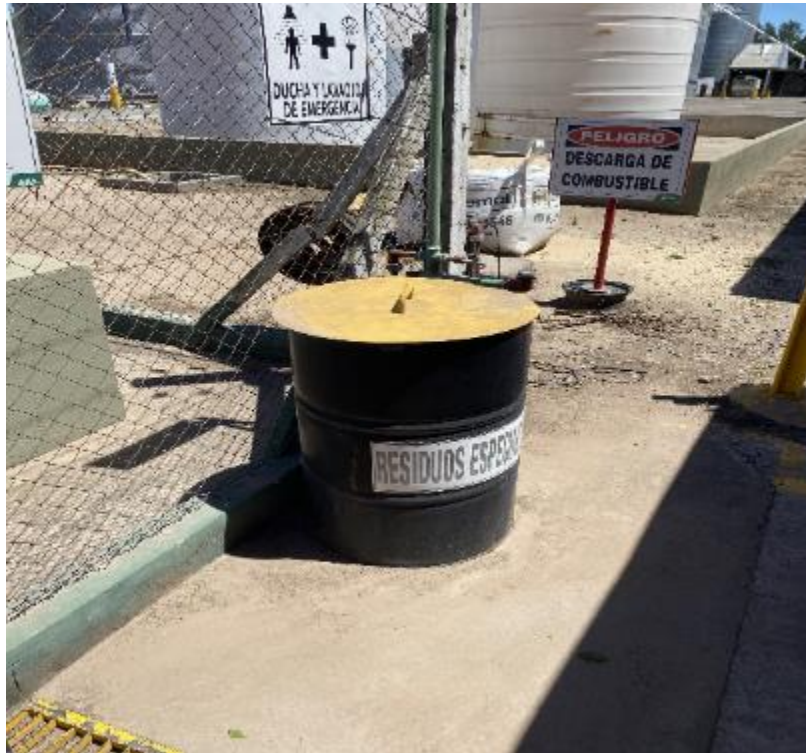
Imagen 16: Recipiente para almacenaje de residuos especiales en sector de combustibles líquidos
