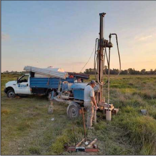
Construcción frea'tmetro F2
