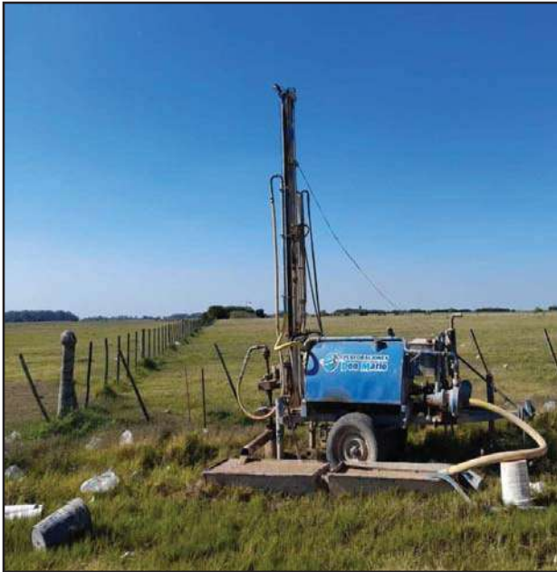
Construcción frea'tmetro F3
