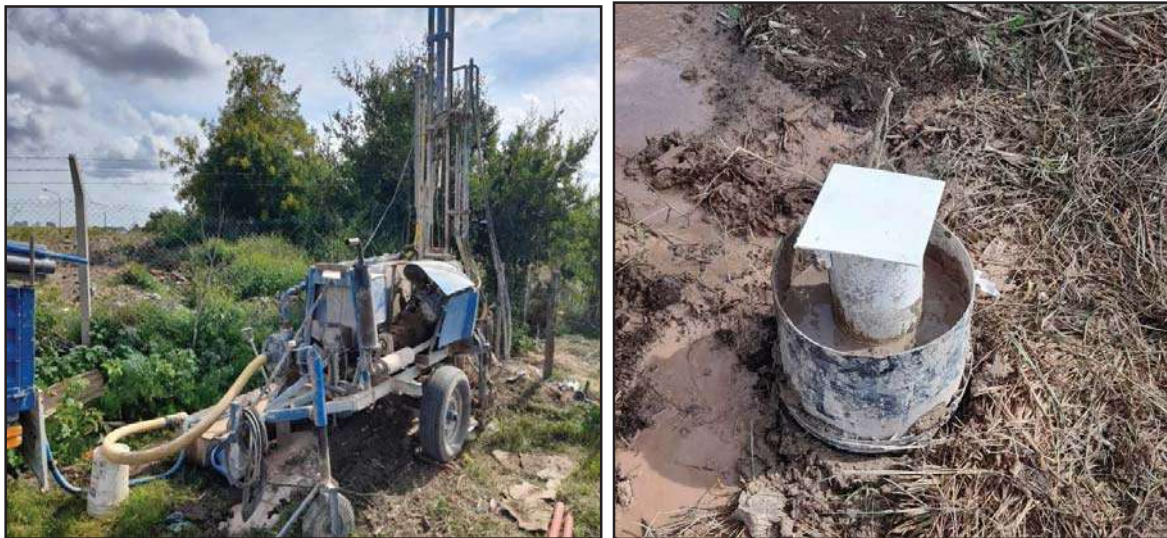
Construcción freático F1
