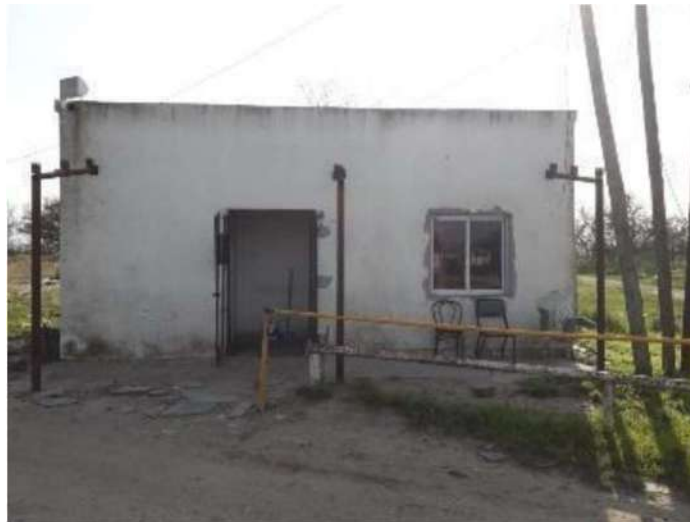
Foto 1. Edificio de acceso al actual BCA.
