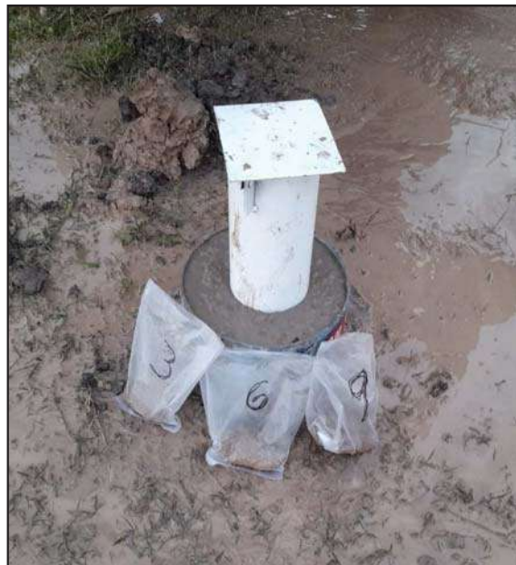
Construcción freático F1
