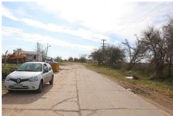
Foto 57. Vista del acceso al BCA.
