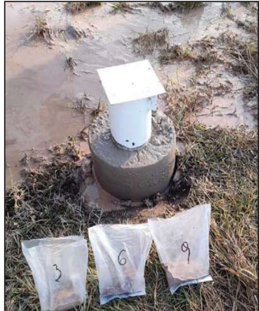
Construcción frea'tmetro F3
