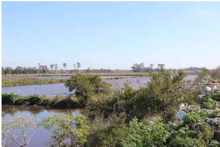
Foto 3. Vista de las lagunas de tratamiento de frigorífico.
