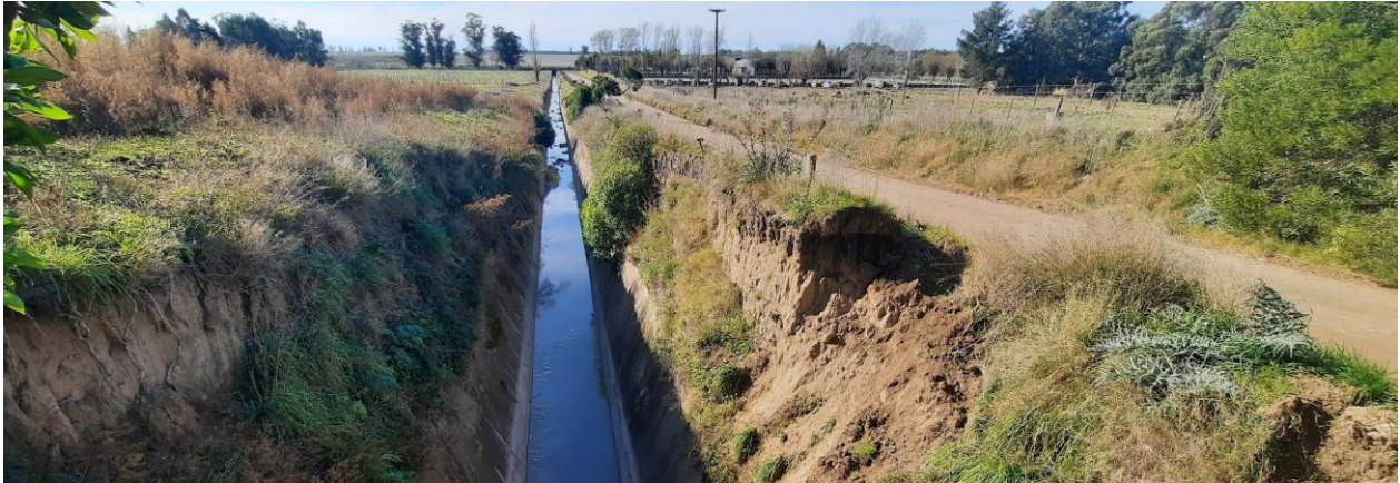
Figura 40: ramal prexistente de Avenida 74 en su segmento a cielo abierto previo a la desembocadura.
