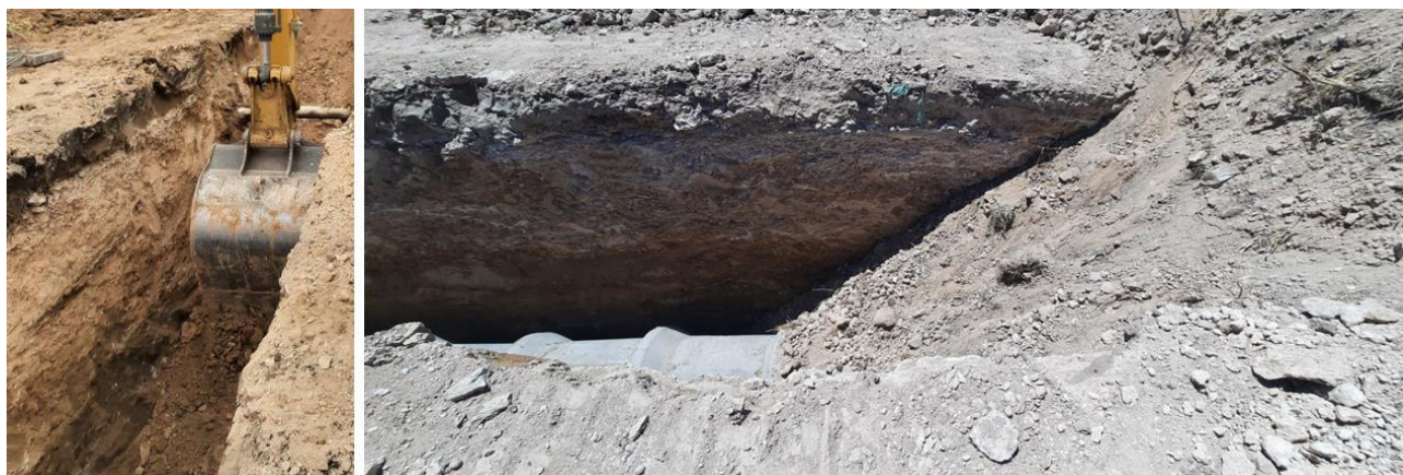
Figura 15: perfil de suelo típico de la zona de proyecto.
