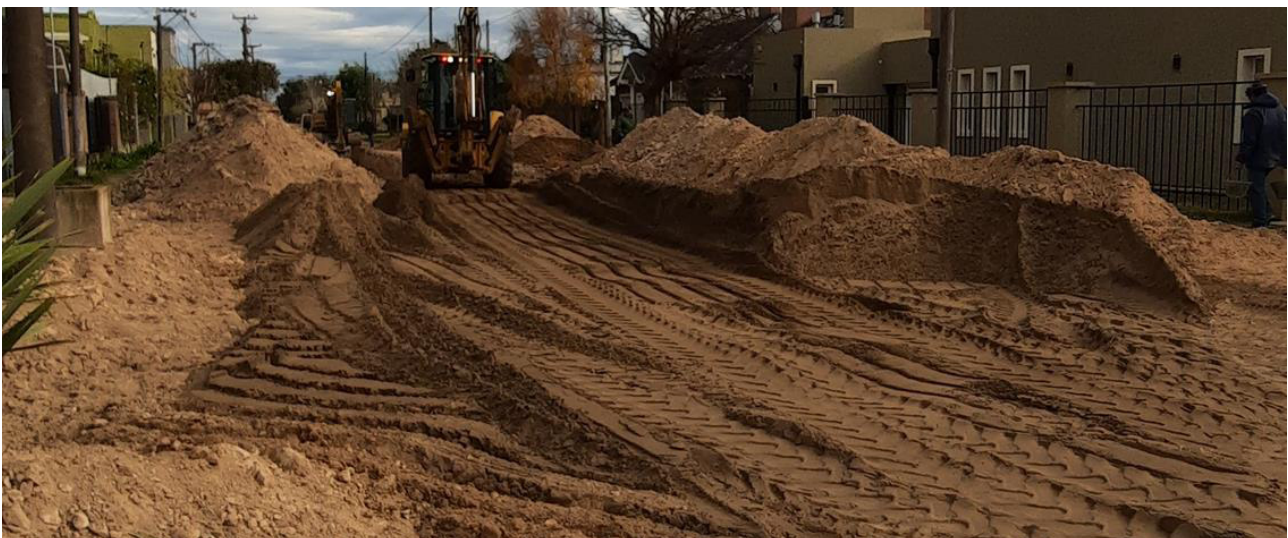
Figura 10: relleno con arena.
