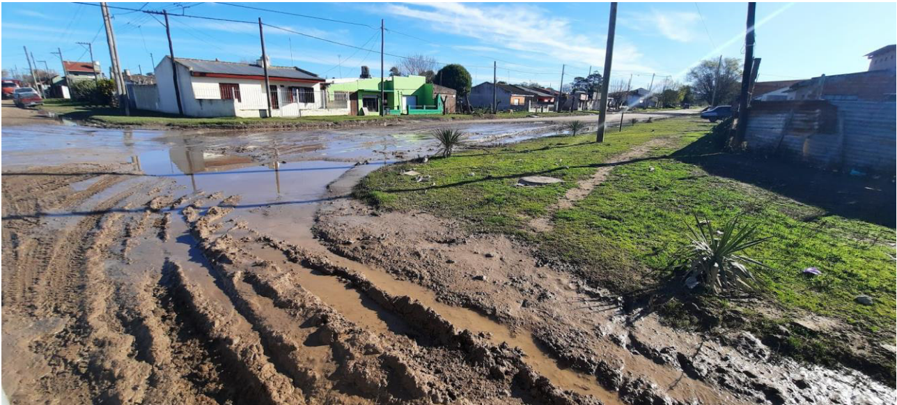
Figura 29: zona residencial con anegamiento localizado.
