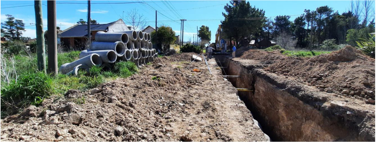
Figura 8: zona de obra pluvial, se observa el tipo de excavación, acopio de suelo extraído y materiales, y las interferencias del sistema sanitario.
