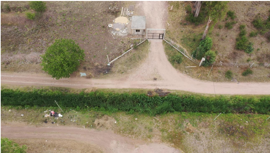
Ilustración 9: Entrada de acceso a construcciones sobre la margen izquierda de la calle San Roque esquina Monroe
