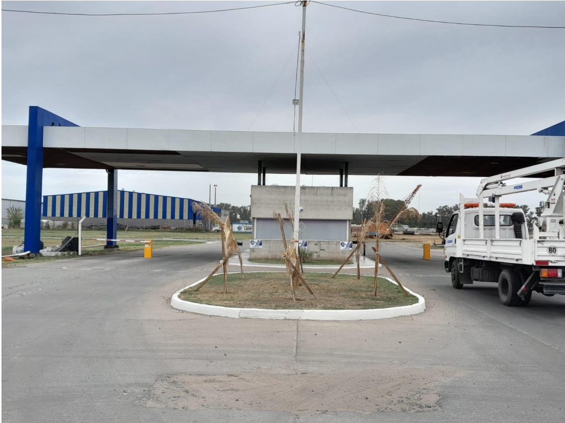
Ilustración 23: Entrada y salida al Parque Industrial Presidente Perón ubicado sobre Av. Néstor Kirchner
