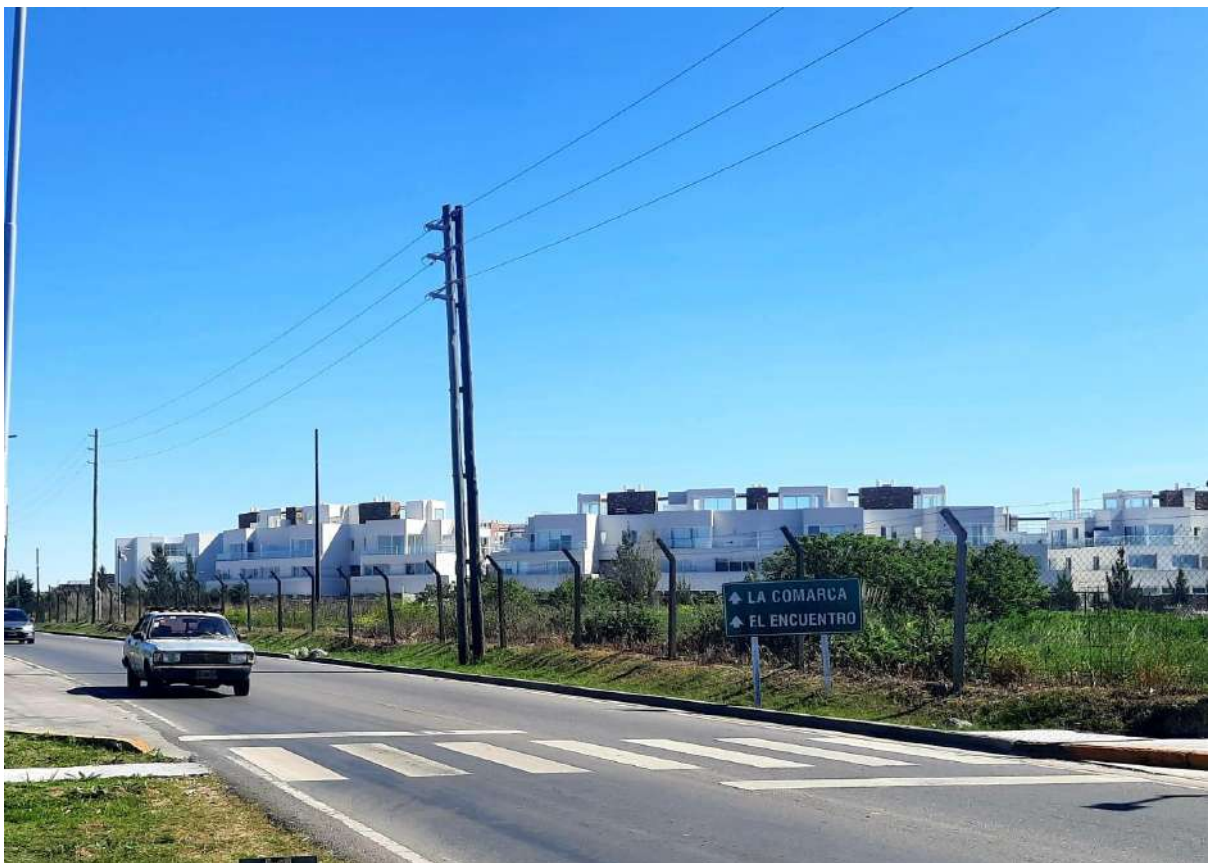
Figura 46. Cruce peatonal sobre Corredor Bancalari-Benavidez, sin semaforización. AO nueva estación.
