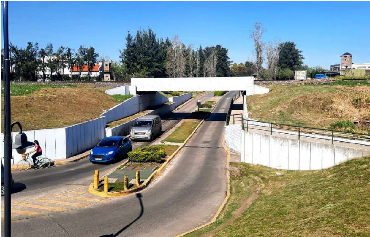
Figura 44. Paso bajo nivel vial y peatonal, vista hacia los barrios Talar del Lago, AO nueva estación.
