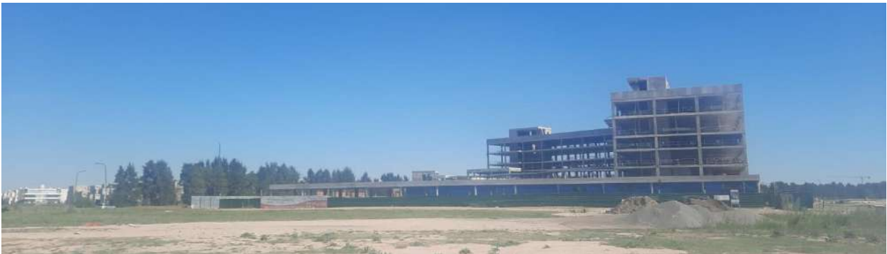
Figura 63. Sanatorio de alta complejidad en construcción en zona del futuro Centro Cívico dentro de Nordelta.
