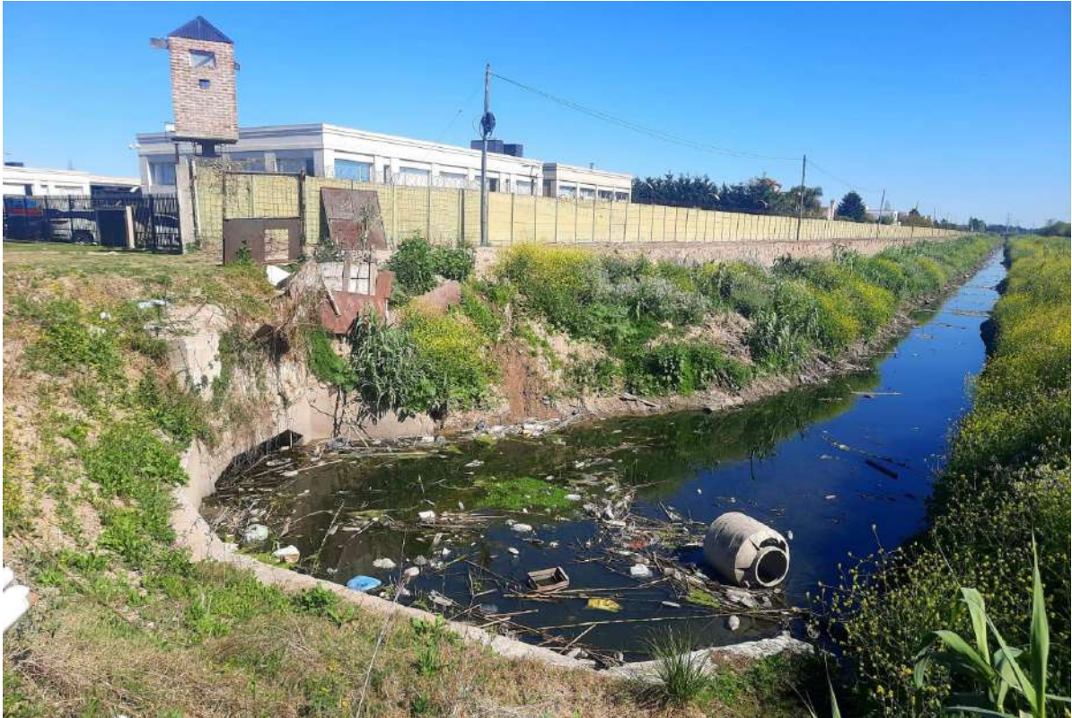
Figura 49. Zanjón que corre entre las vías y el paredón del Centro Comercial del barrio cerrado Talar del Lago II, AO nueva estación.
