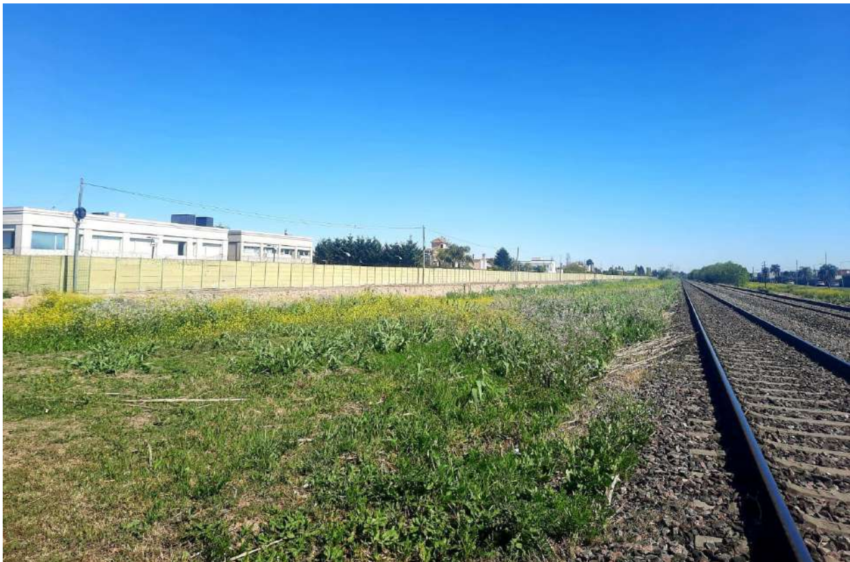
Figura 50. Parquizado junto a las vías del tren y el paredón del Centro Comercial y el Barrio Cerrado Talar del Lago II.
