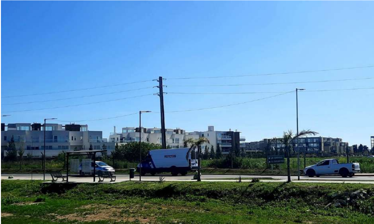
Figura 45. Corredor Bancalari - Benavidez, vista hacia Barrio Los Castaños en Nordelta. AO de la nueva estación.
