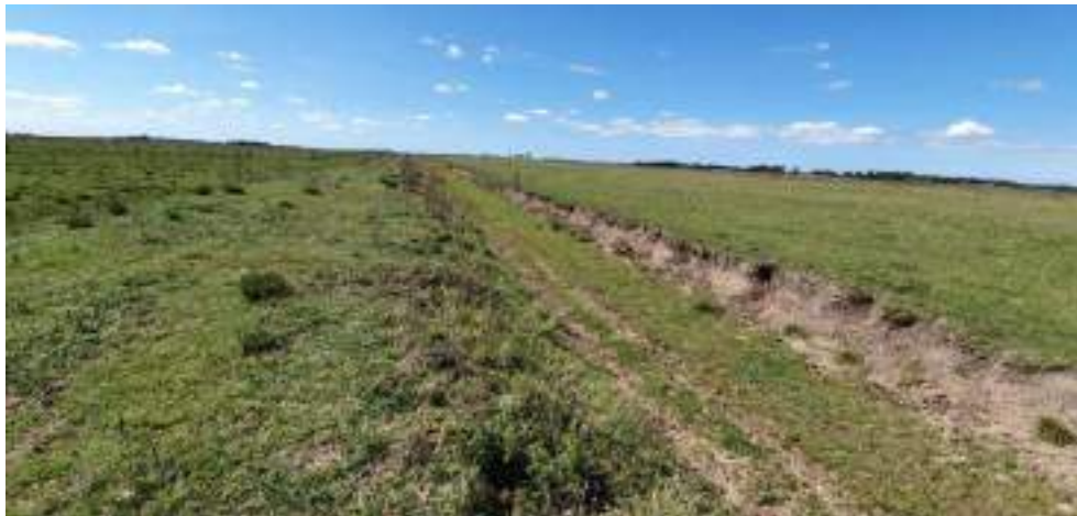
Imagen 11. Vista canal de drenaje artificial en el área del proyecto
