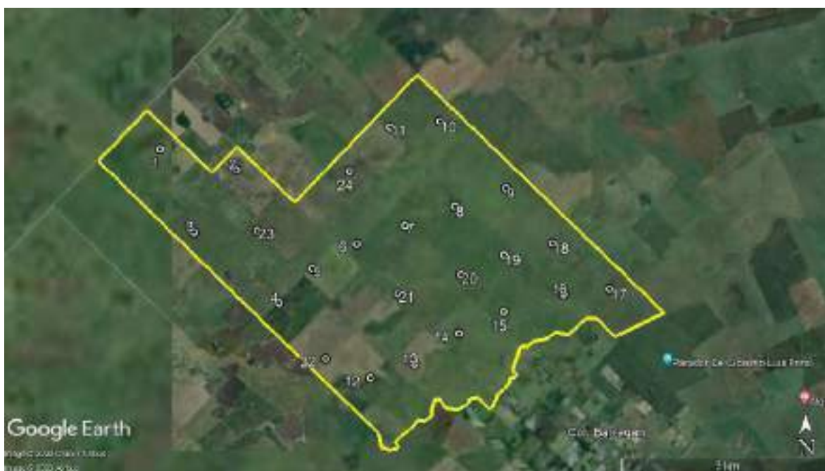
Imagen 1. Ubicación de los aerogeneradores. Fuente. GENNEIA S.A./Google Earth.
