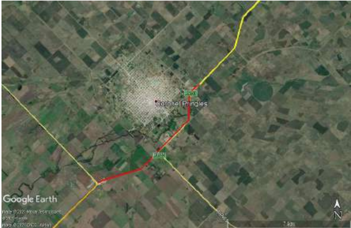
Imagen 4. Cruce RP N°85 - Acceso Cnel. Pringles. Fuente. Google Earth.
