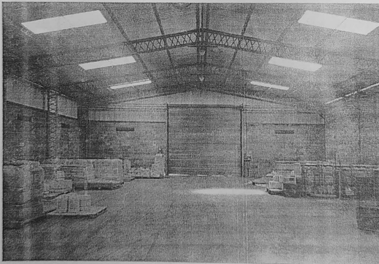
Depósito de Agroquímicos (vista interior).
