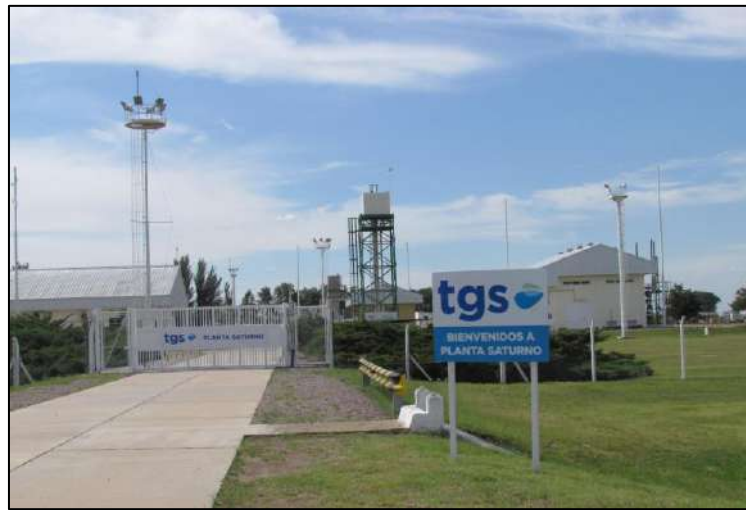
Foto N° 19: Punto ID N°97. Planta Compresora Saturno, partido de Guaminí.
