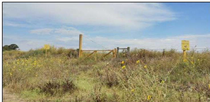
Foto N° 17: Punto ID N°95. Tranqueras y cartelería del paso de gasoducto existente.
