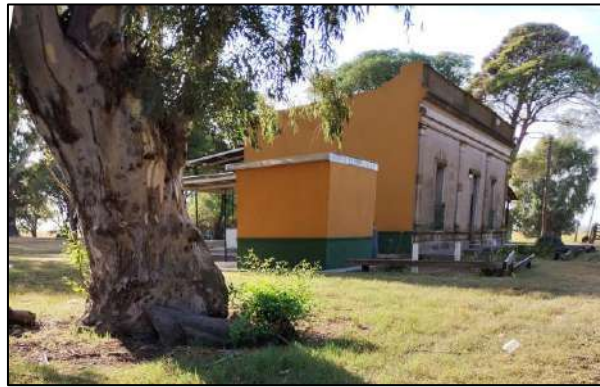
Foto N° 10: Punto ID N°71. Casona refaccionada en casco de estancia próximo a Trenque Lauquen.
