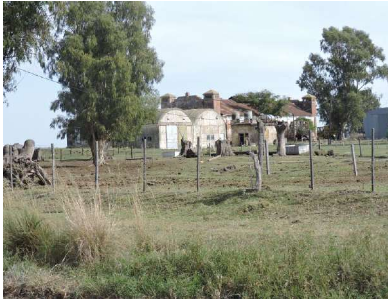
Imagen c. Edificaciones en las adyacencias al monte de eucaliptos (a más de 200 m de la traza).
