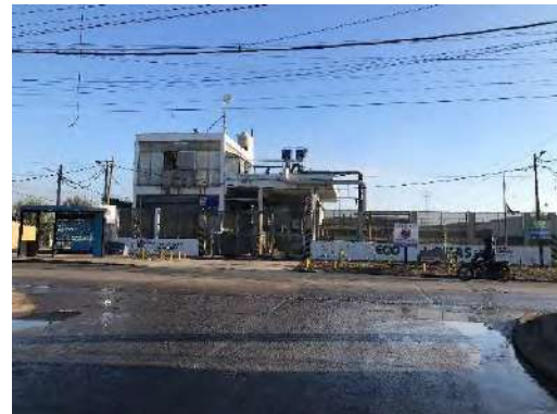
Foto 04: Desde Calle 4 Planta Santa Catalina - Quiroga y Unión.
